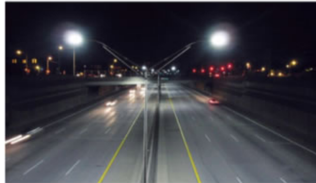
Autopista, sustitución de luminarias LED de alumbrado público
